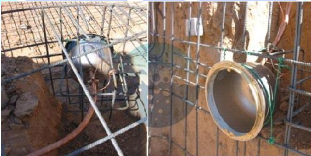
تصویر نحوه اجرای یک نمونه کاسه چراغ قبل از بتن ریزی
