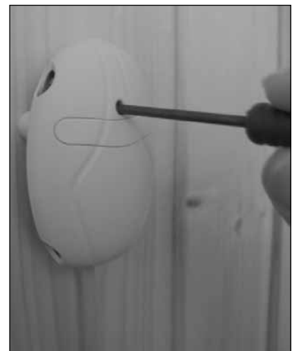
Figure 15. Reset button for overheating limiter Abbildung 15. Rücksetzknopf des Überhitzungsschutzes
